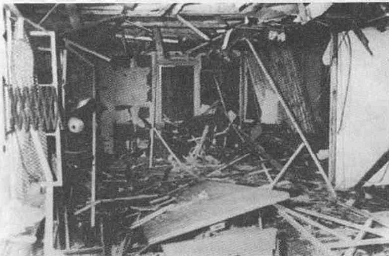
Așa arăta sala de consfătuiri după explozie.
